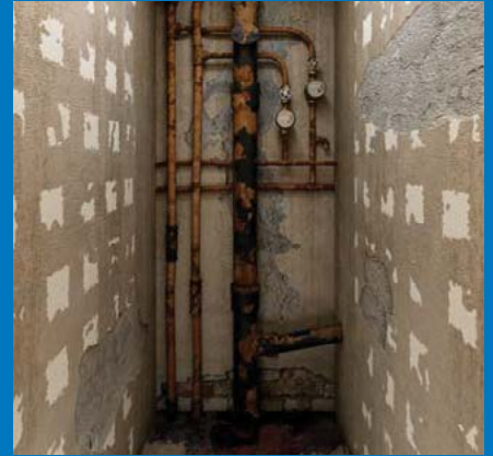
Типовой санузел готов к установке новой системы.
