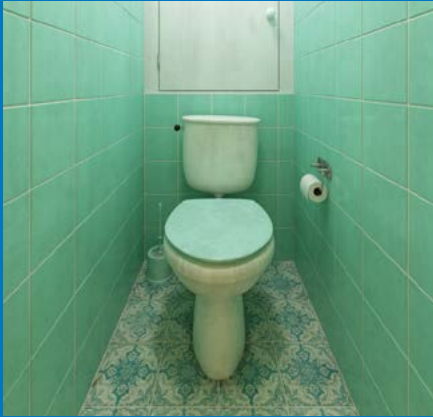
Типовой санузел до реконструкции.
