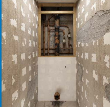
Плитка, старый унитаз и задняя стенка удалены.
