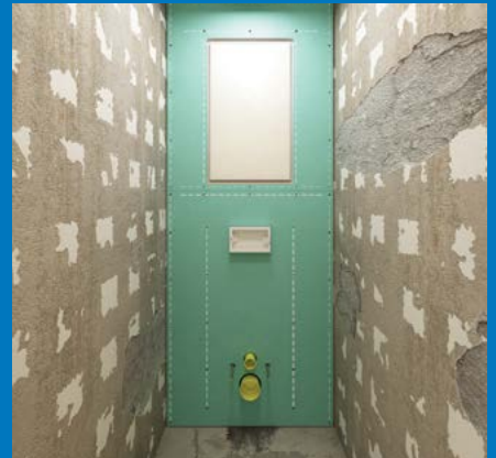
Установка сантехнического скрытого лючка для доступа к вентилям и счетчикам.
