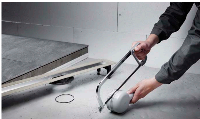
Путем простого подрезания ножовкой стандартную модель сифона на месте можно превратить в модель для реконструкции.
